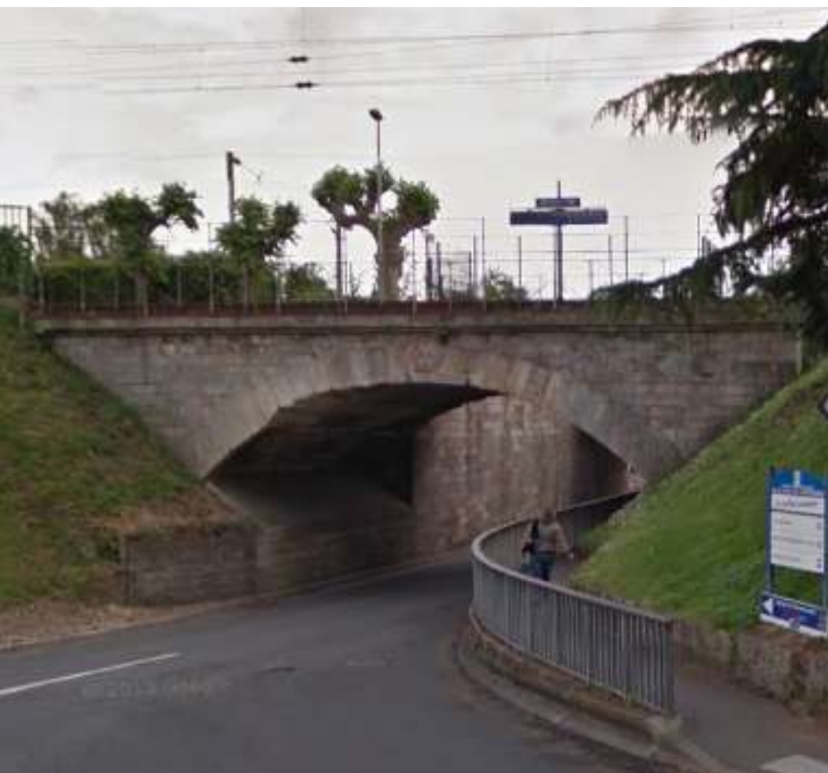
Vue depuis la gare de Louvres
