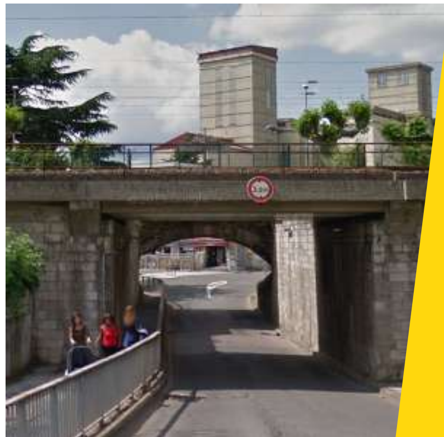
Vue vers la gare de Louvres
