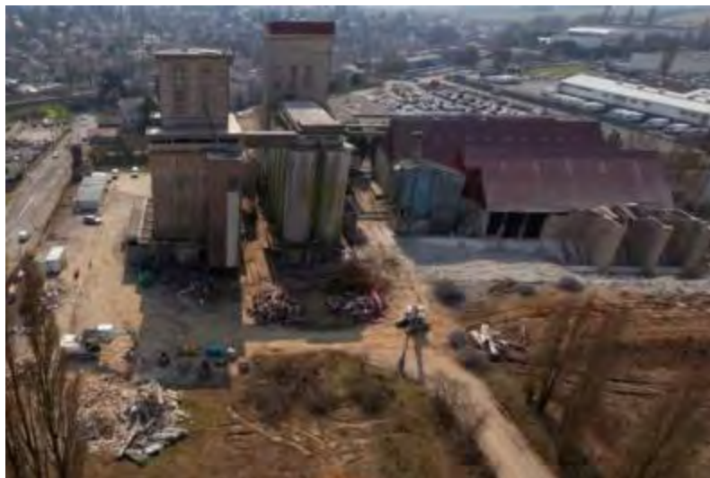
Le chantier de démolition le 27 mars 2013
