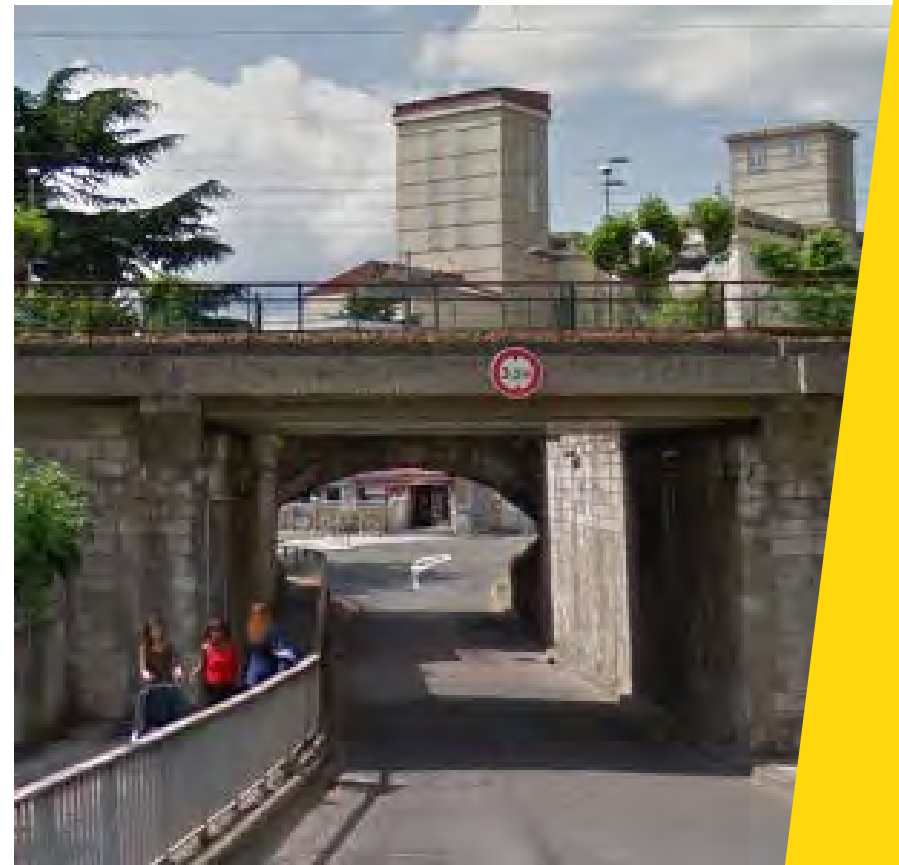
Vue vers la gare de Louvres
