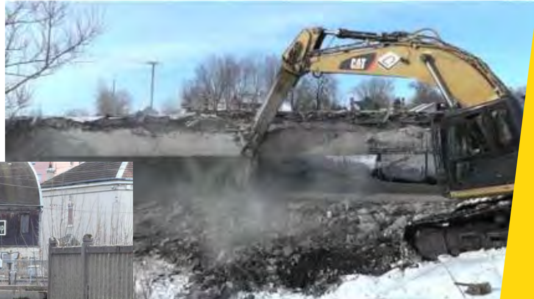
Démolition d'un pont au Quebec
