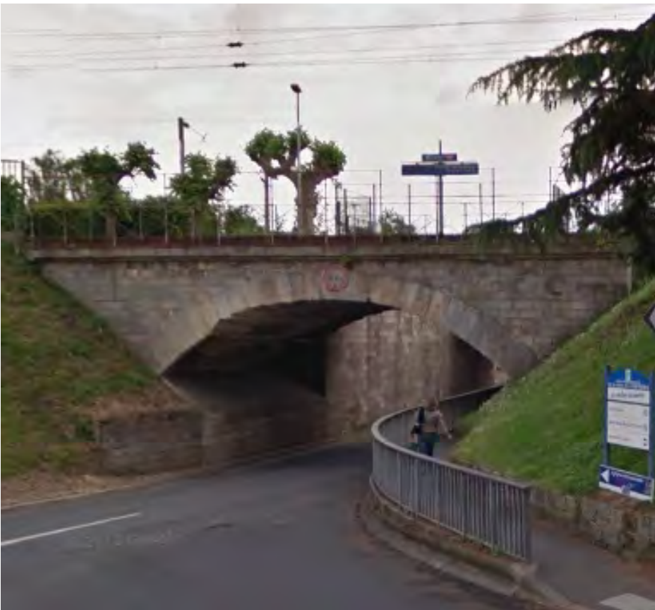
Vue depuis la gare de Louvres
