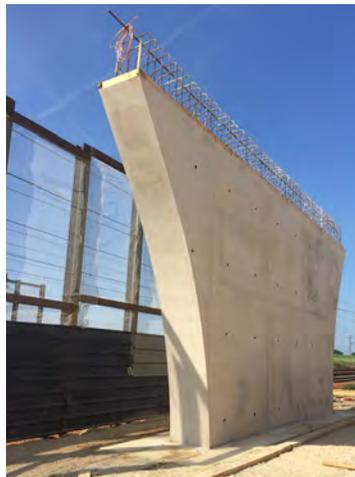
Pile supportant le tablier à l'abri des écrans de protection
